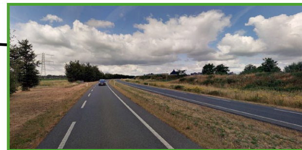
Twee rijbanen met een berm er tussen Referentie: N314 ter hoogte van de wijk De Leesten te Zutphen
